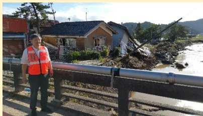
輪島市町野町地内（氾濫）
