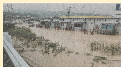
輪島市宅田地内（仮設住宅浸水）
