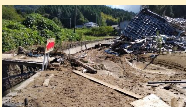
輪島市稲屋地内（氾濫）
