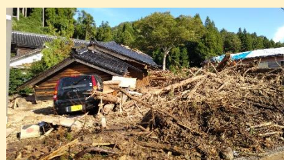
輪島市町野町地内（土石流）
