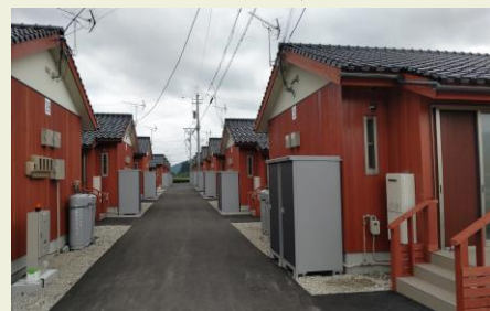
団地内仮設団地
