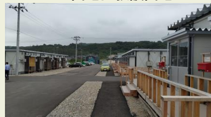
団地内仮設団地
