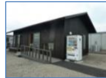
仮設住宅団地 集会所
