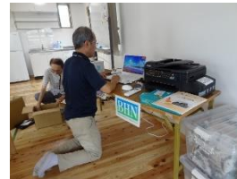
ICT設備設置工事 (集会所)
